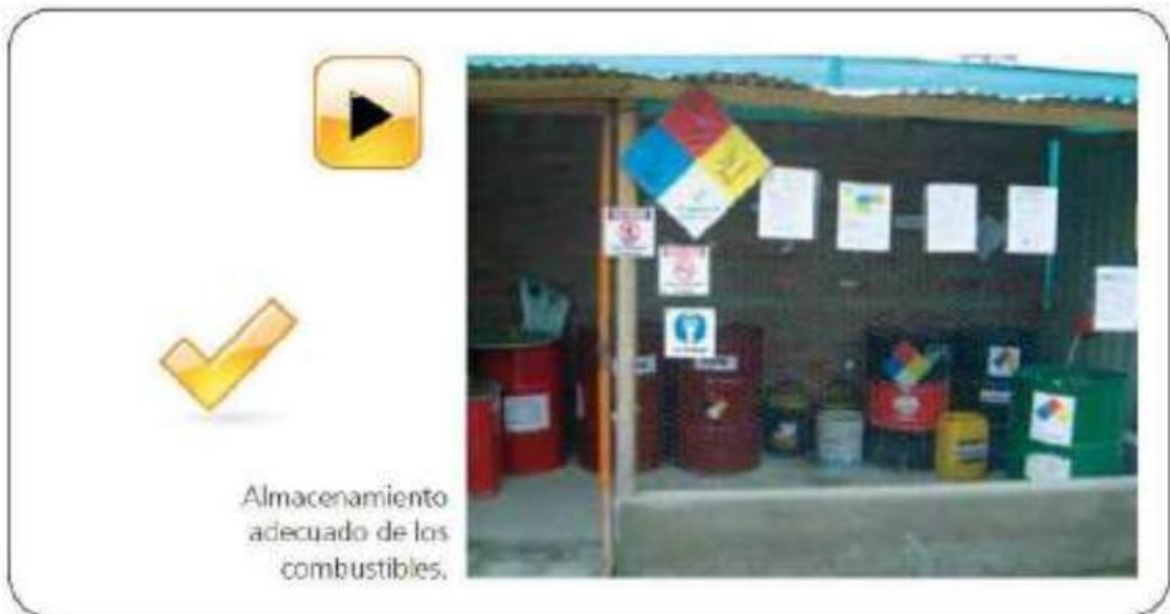
Figura. Manejo adecuado del almacenamiento de materiales en la obra.
